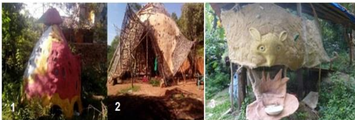
Figura 4 -Bioconstrução na Ong. Çarakura – Florianópolis – SC: 1. Banheiro no formato de Sarakura construído com bambu e Calfetice (Cal+Fibra+Terra+Cimento), 2. Local para palestras, em processo de construção, utilização de bambu e Calfetice, 3. Banheiro Seco no formato de Tatu, construído com a técnica Cob e Calfetice.
