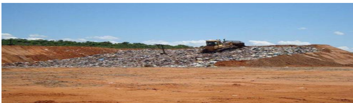
Imagem 6 - Máquina realiza nivelamento do resíduo. Fonte: site da empresa.
