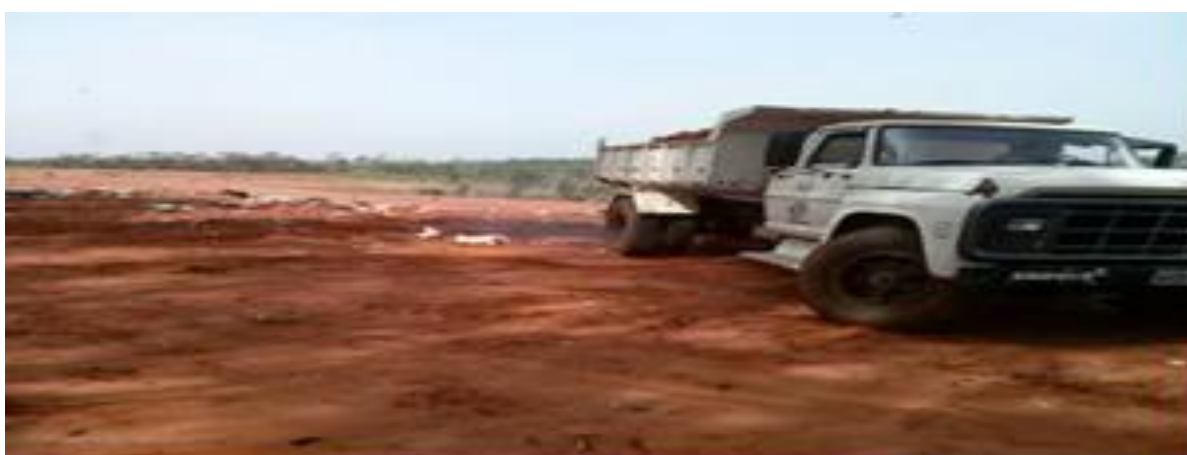
Imagem 1 - Caminhão realiza cobertura o material depositado. Fonte: autores.
