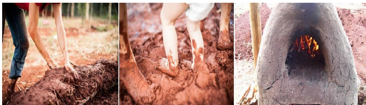
Figura 5 - Técnica Cob utilizada para construir mobílias.
