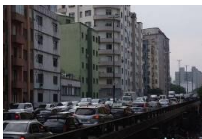
Figura 1: Vista Elevado Costa e Silva Fonte: Sobrinho (2014)
