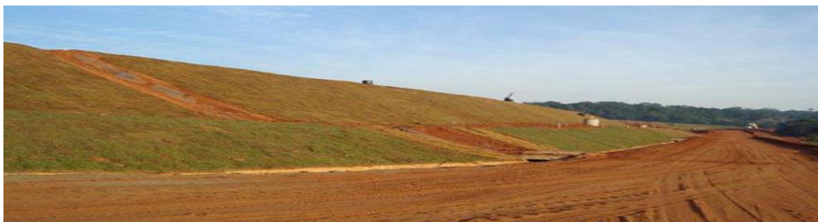
Imagem 5 - Vista do aterro.
