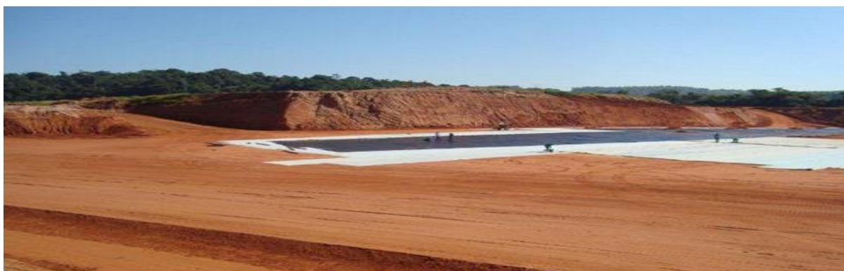
Imagem 7 - Impermeabilização do solo. Fonte: site da empresa.
