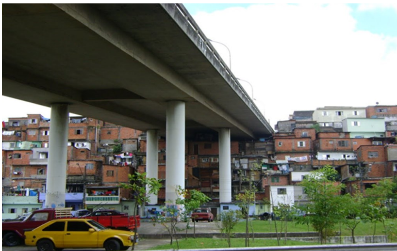
Figura 7 - Vista da ocupação Jau-Bueru, junto ao Viaduto Cangaíba
