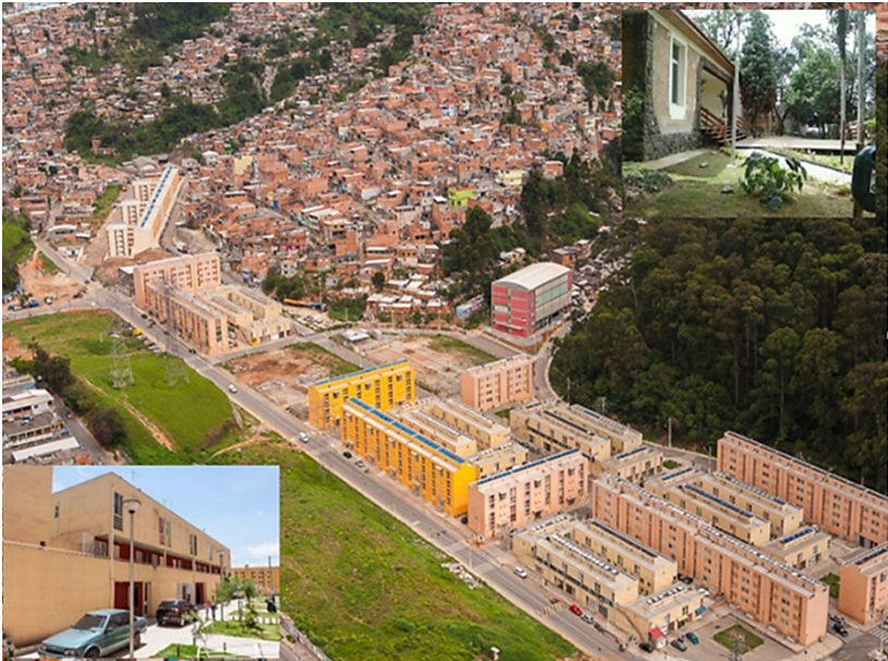
Figura 10 - Imagens da intervenção
