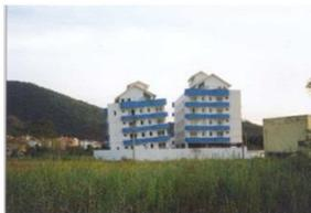
*Ocupação inadequada em terreno silto-argiloso sujeito a recalque*
