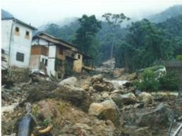
*Corrída de solo e blocos atingindo edificações construídas em vales sujeitos a esse processo*
