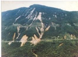
*Aceleração de movimentos gravitacionais de massa pelo fluxo de água proveniente das estradas e disposição de bota-fora nas encostas*
