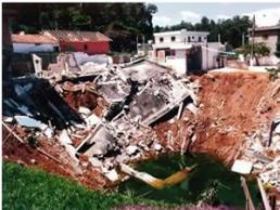
*Aceleração de subsidência cárstica pela captação de água subterrânea*
