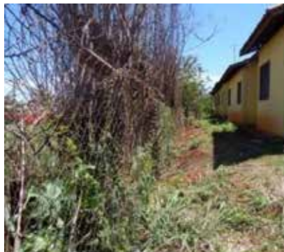
Situação de vulnerabilidade e deslizamento do terreno (MONTEIRO, 2014).
