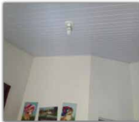
Teto forro PVC: por meio TAC, parceria Ministério Público (MONTEIRO, 2015).
